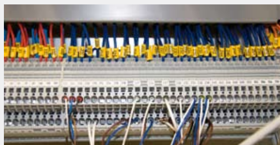
Elektroniken. All extern anslutning görs via snabbplintar som förenklar installationen.
