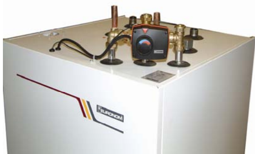
Figur 6 Anslutningar Exotank VPS.
